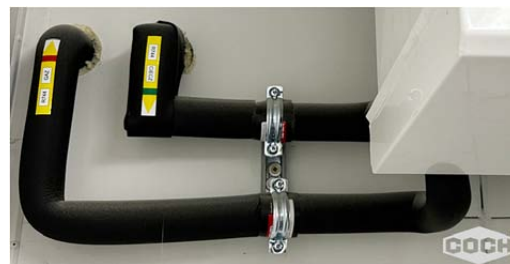
Rys. 6. Przykład rurociągów czynnika chłodniczego (źródło: [10])
